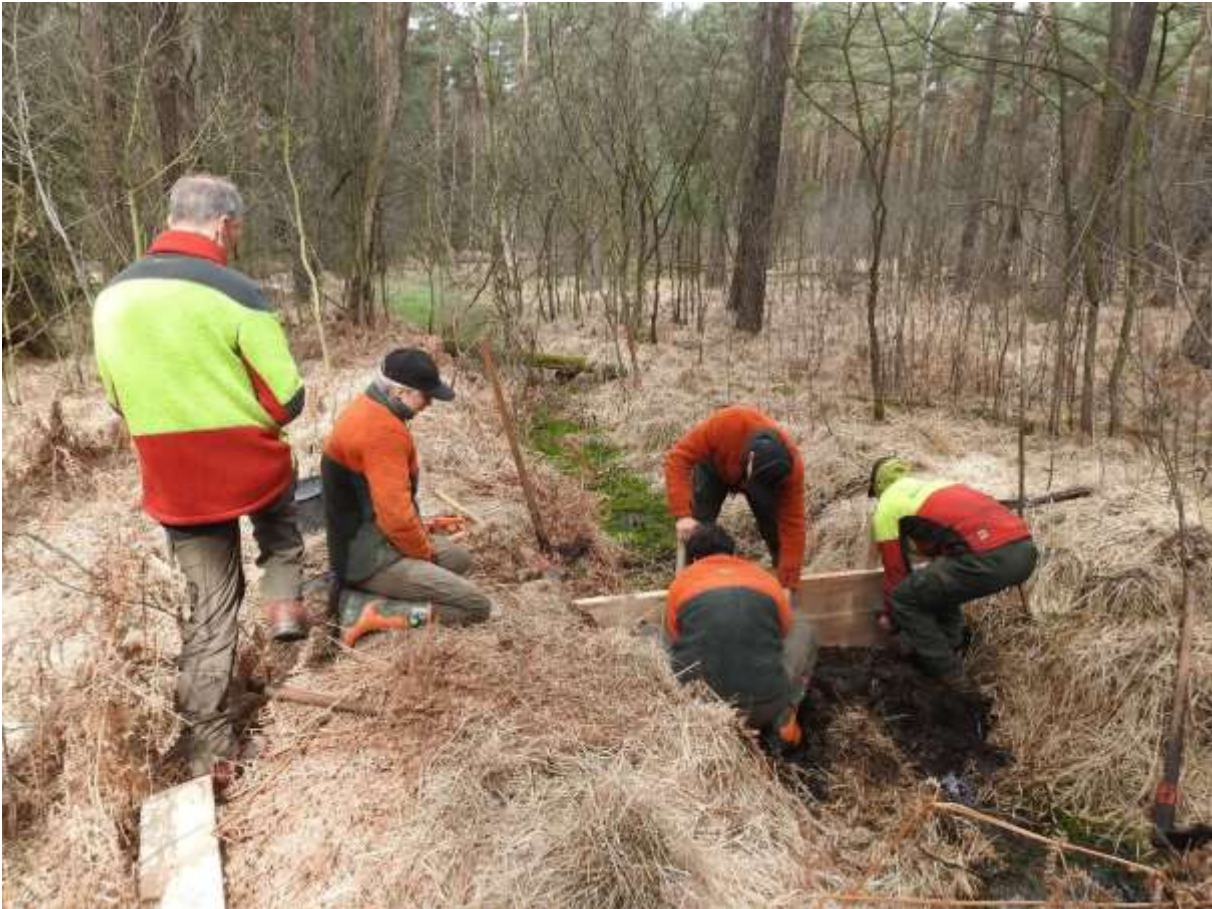
Abb. 2: Die Auszubildenden verschließen mit unbehandelten Eichenbohlen die flachen und schwach fließenden Entwässerungsgräben der alten Teichanlage. (Aufn.: M. Schrack, 22.04.2021).
